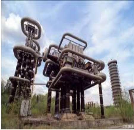
Instalaciones del Proyecto SURA (Foto11)
